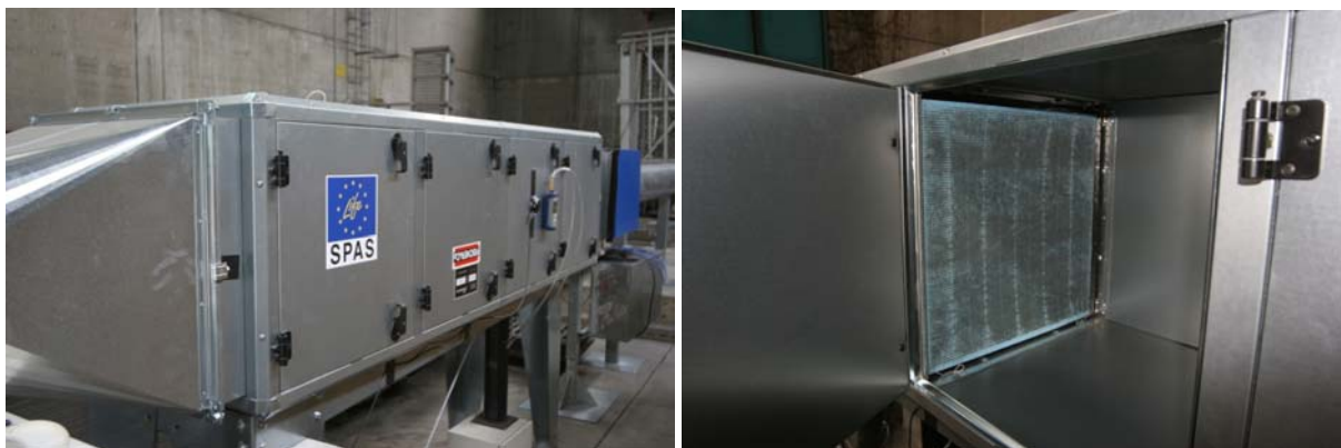
Abbildung 4: Filterkasten (links) und Filterhalter mit eingebautem Testfilter (rechts)
